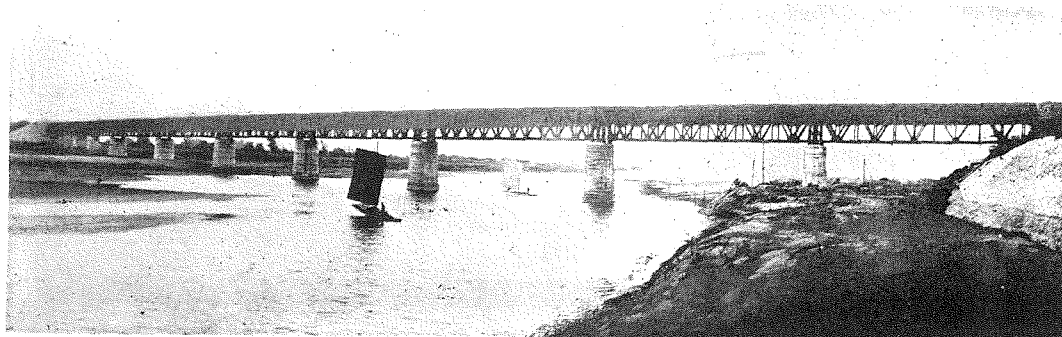
曾文溪橋全景。橋長1,119尺、徑間長120呎九連。
