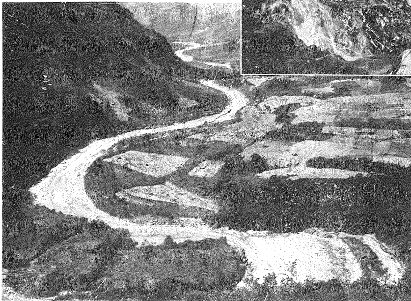
(7) 霧社附近横斷道路より萬丈方面に 向ひ濁水溪を望み、右岸の開懸狀 ↓ 態を示す。
