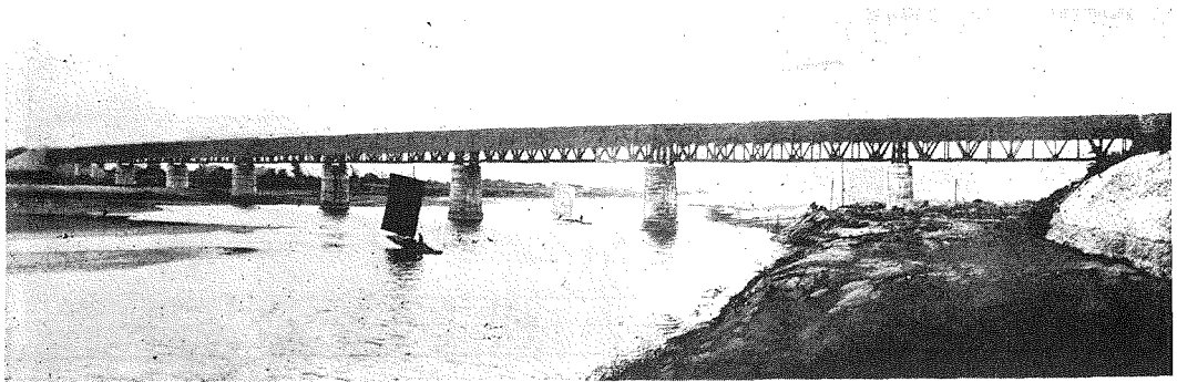
曾文溪橋全景。橋長1,119尺、徑間長120呎九連。
