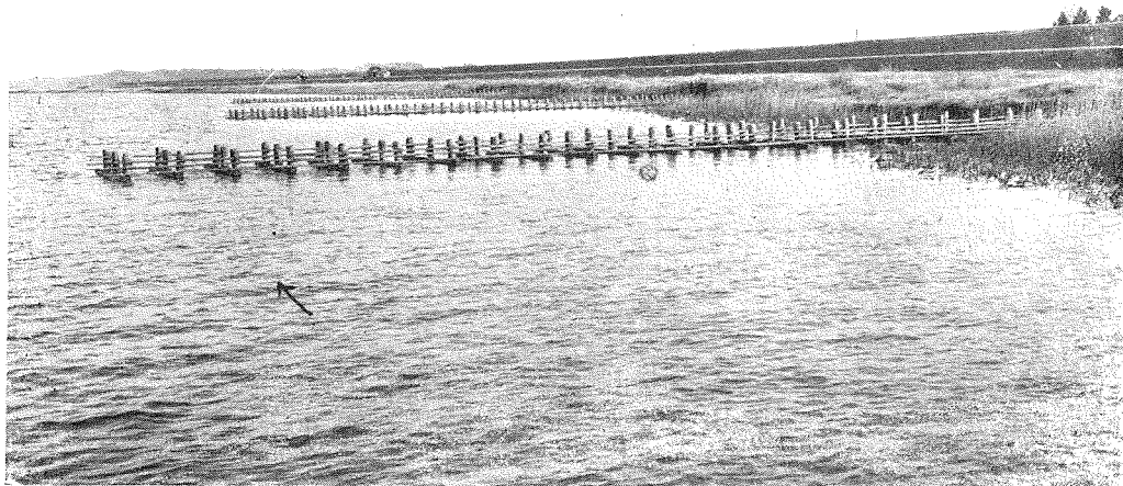
(20) 杭を三列に打ち竹籠を張りたる水制にして水深き個所に沈澱を誘ふものとす。
