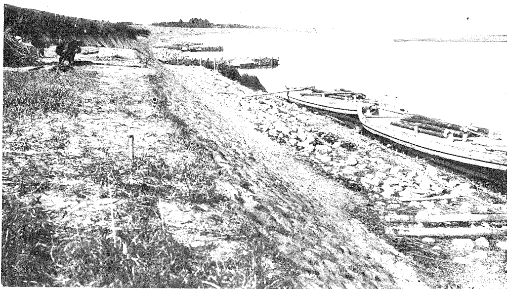
(19) 普通の石張護岸にして根固沈床を有す、其前方を浅くするため枕出水制を設けたり（中利根、木間ヶ瀬村）
