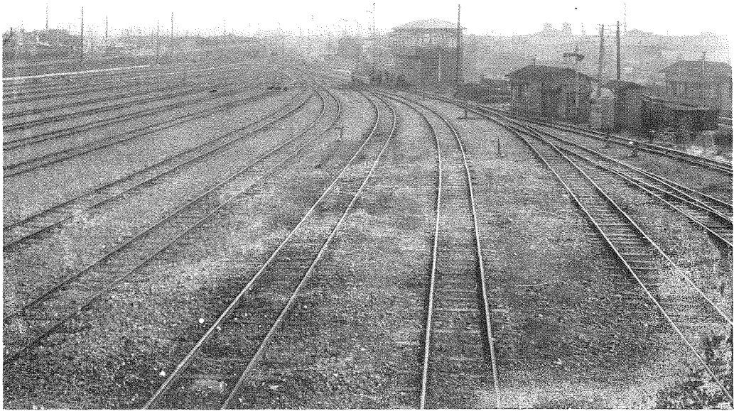
(3) 尾久客車操車場。左端東北本線より順に出發線、收容線、到着線を望む。
