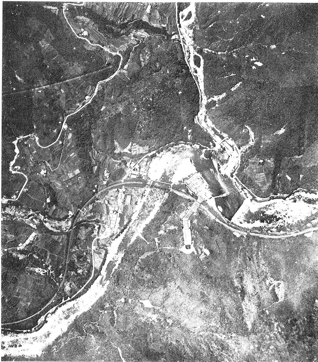
(1) 木曾川上流、讀書發電所全景。
