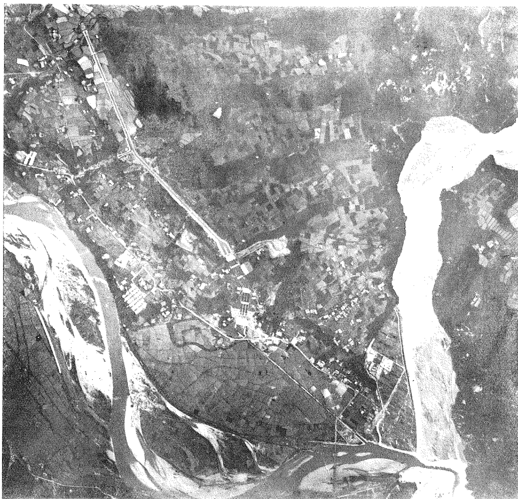
(2) 天流川上流、南向發電所全景。
