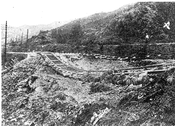
第 3 2 圖 築 堤 と 水 害
