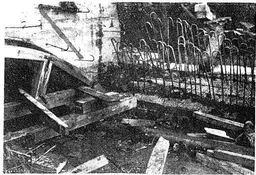
(9) 西口斜拱部鐵筋補強
