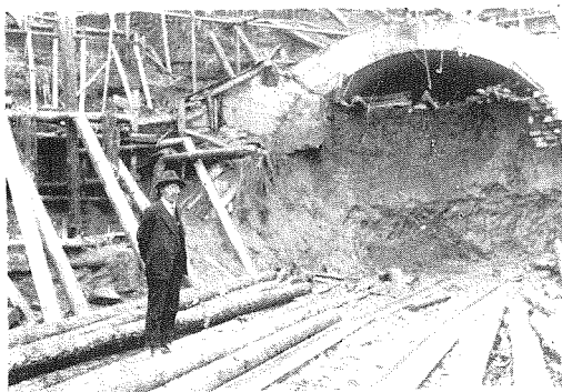
(10) 各掘鑿坑混凝土填充を了し、大拱を成す(西口)
