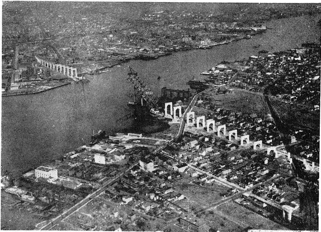
(2) 空中より見たる工事中のキル・ヴァン・ケル橋 (1930年3月15日)
