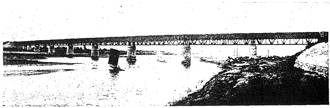
曾文溪橋全景。橋長1,119尺、徑間長120呎九連。
