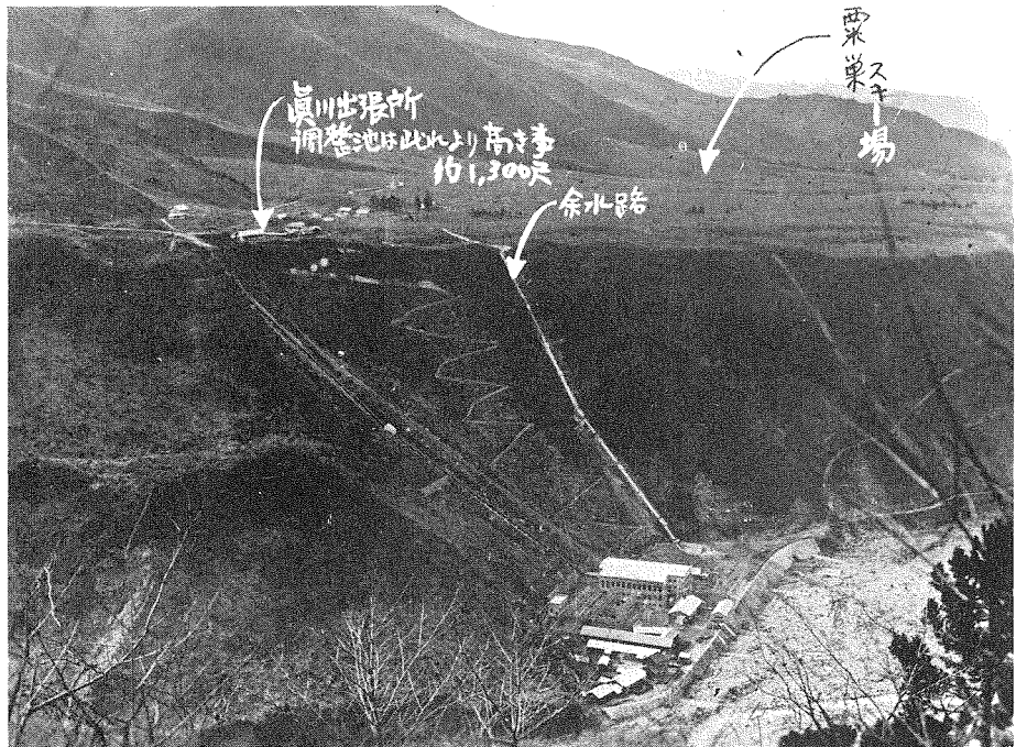
(12) 發電所發電室は間口四十五尺奥行百四十五尺にして床面より構梁迄の高さは三十五尺なり。 本屋に接続して間口二十四尺奥行九十六尺の三階建を設け之れを配電盤室、事務室、諸器具置 場とせり。
