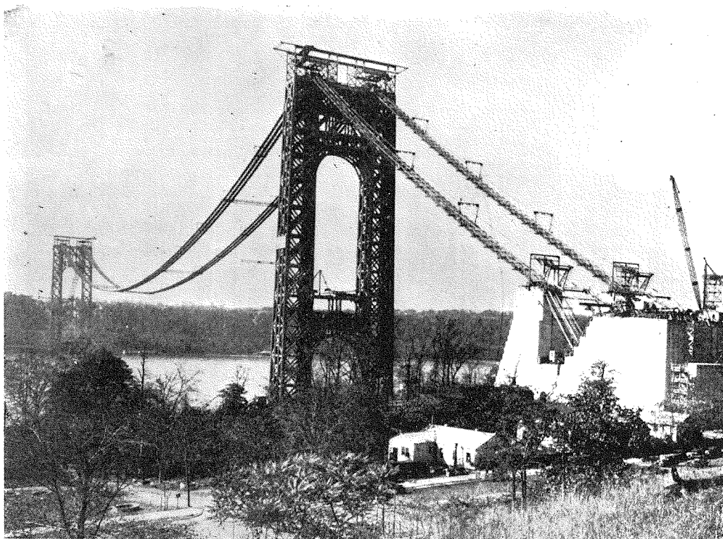
(2) 鋼索架渡中のハドソン橋。(紐育側)
