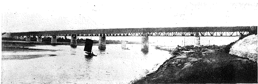
曾文溪橋全景。橋長1,119尺、徑間長120呎九連。
