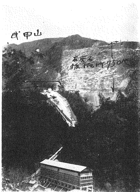
第1圖 碎石場全景、表土を除去せる狀況を示す
