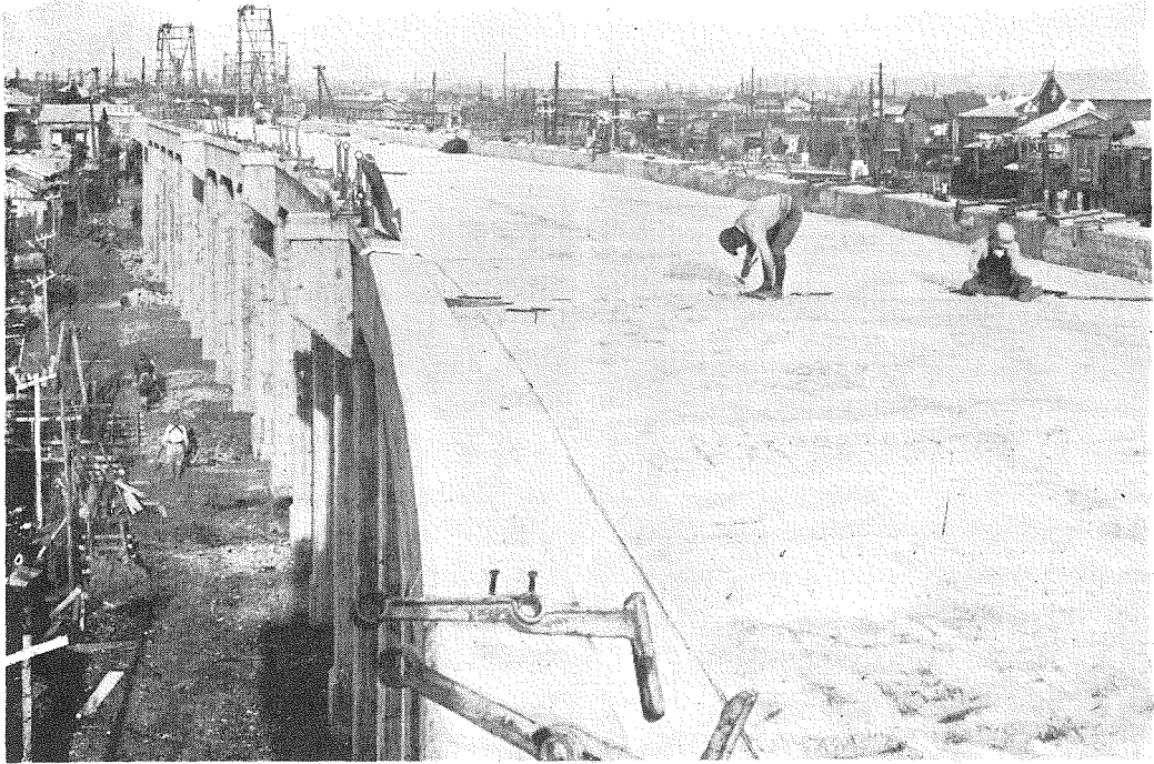
(7) 市内高架橋手摺取付及エキスパンション・ジョイントの防水工事
