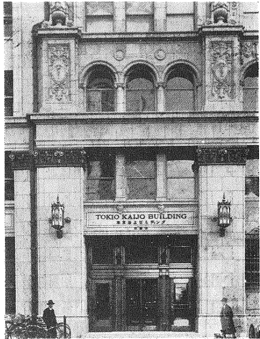
(6) 新館正面入口
