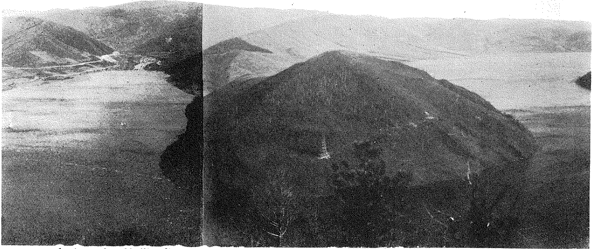
(ニ) 右方木柱塔は索道、索道延長9哩半、一日の輸送能力200噸 (ホ) 取入口は寫眞右端より2里の上流にあり。
