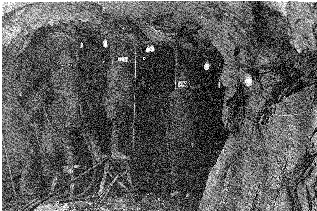
第1圖 清水トンネル導坑鑿岩作業
