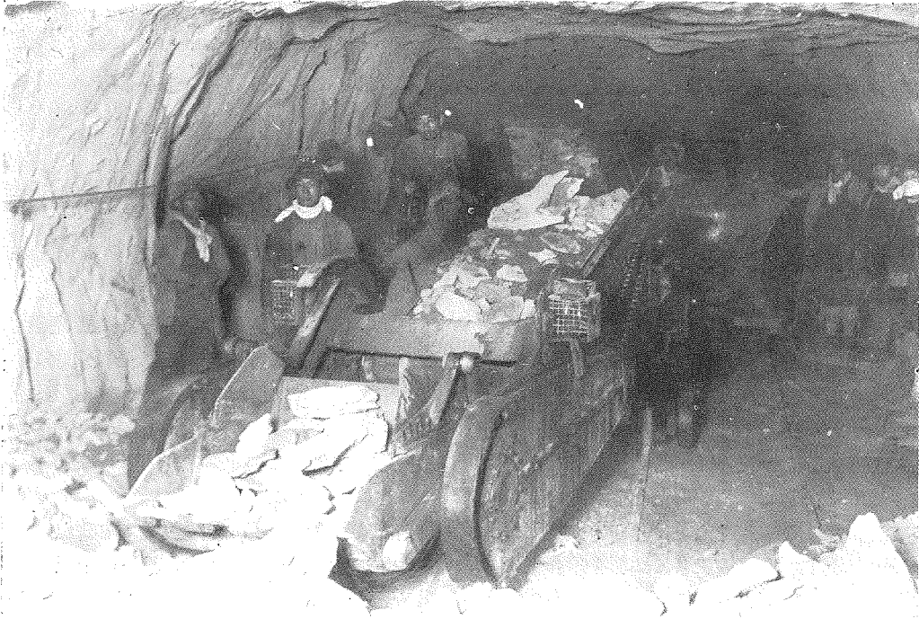
第 3 圖 清水トンネル土合口坑内礫出作業中の状況にして、マイヤース、ホーレー、シヨベルを使用す。
