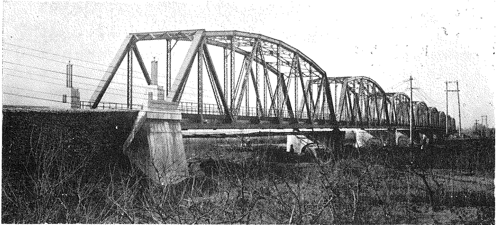
第 3 圖 村山橋全景
