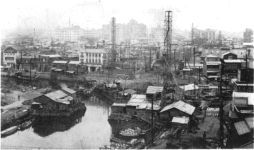
第3圖 三吉橋、橋脚工事中の景
