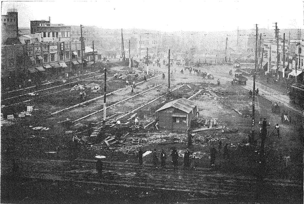
第3圖 和泉廣場工事中、圖の中央上が和泉橋、竣工は今春四月頃の豫定。
