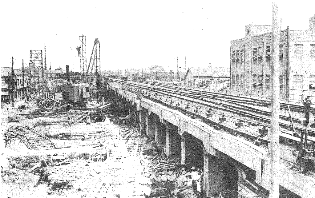
第6圖 同上、龜澤町スラブ橋基礎杭打工事中の景
