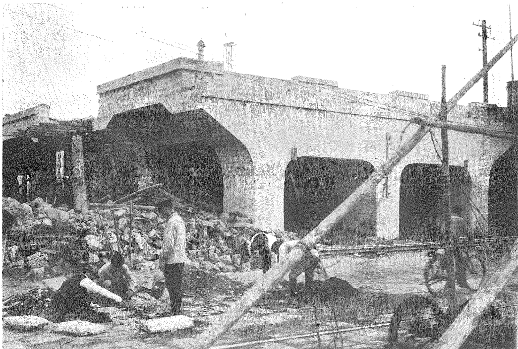
第5圖 兩國橋龜戸間線路増設工事の一部、總武本線0哩17鎖附近、龜澤町スラブ橋工事中 (昭和4年10月24日)
