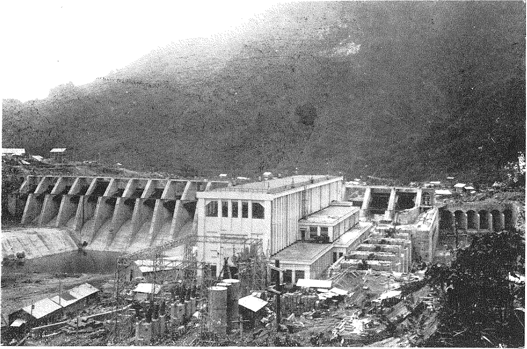
第2圖 豐實發電所全景、下流左岸よりの景。總容量 66,000 K.V.A.。總馬力數 96,000HP.
