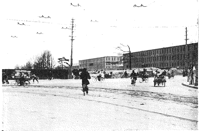
(第56圖) 同上施工前の景
