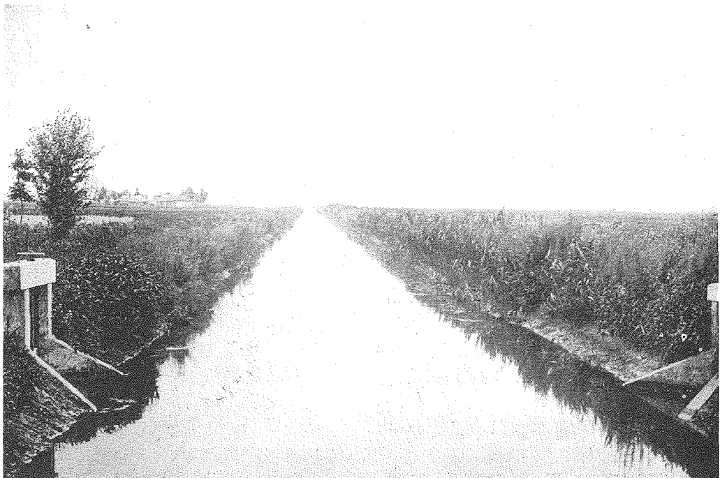
第3圖 揚水機幹線溝路の一部
