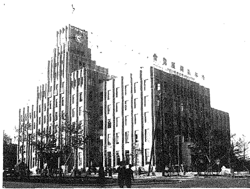
(1) 東京市政調査會館及公會堂正面全景
