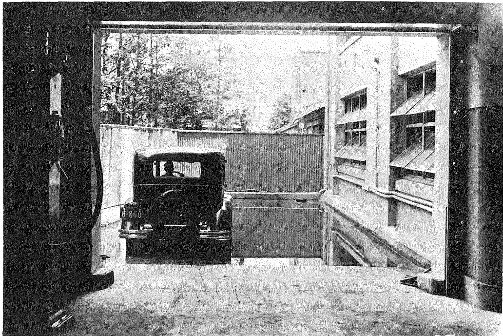
(4) 自動車洗場。車輪の \frac{1}{3} がつかる位のプールになつてゐる。泥で汚れた自動車は、入庫前此處で奇麗に洗はれる。
