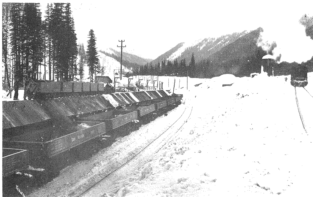
(47) 隧道東口に於ける礮捨の狀況。
