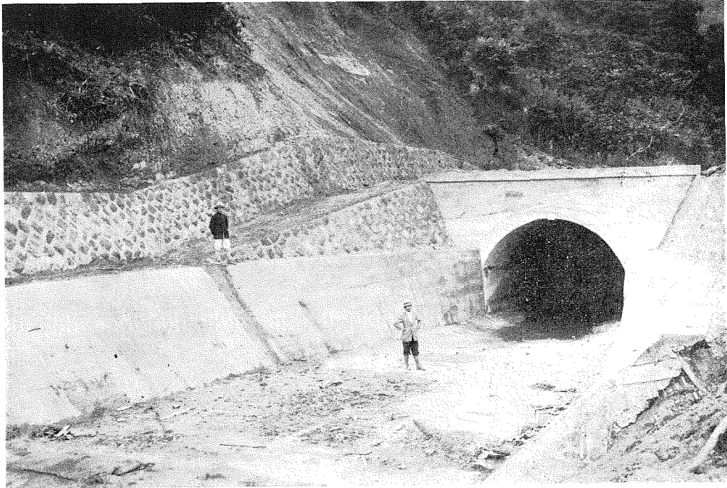
第10圖 第一號隧道
