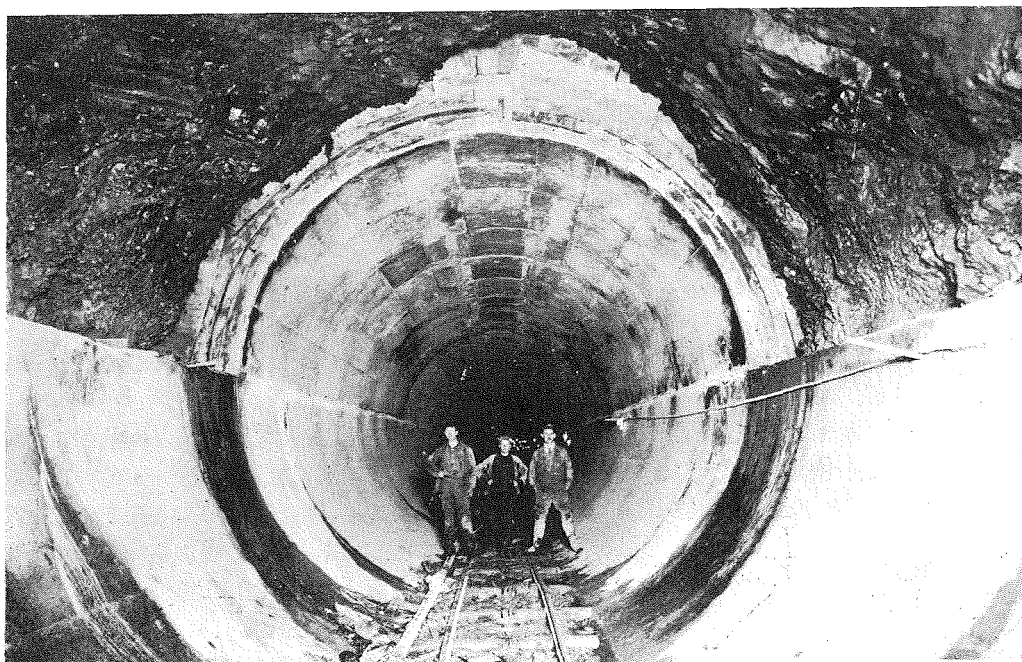
第3圖 ニューヨーク市水道隧道工事、混凝土捲立完成部分の景
