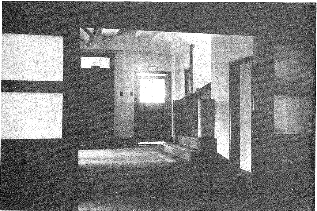
(7) 玄関待合室より階段を望む
