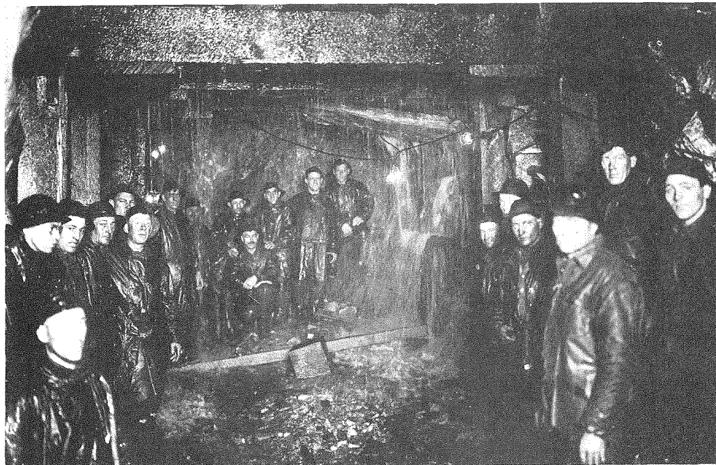
(38) 西口前進隧道に於ける湧水。(1927年3月20日大湧水に遭遇し最大量約 10,000gal./min. に達したが漸次減水して約 6,500 gal./min. になった。)
