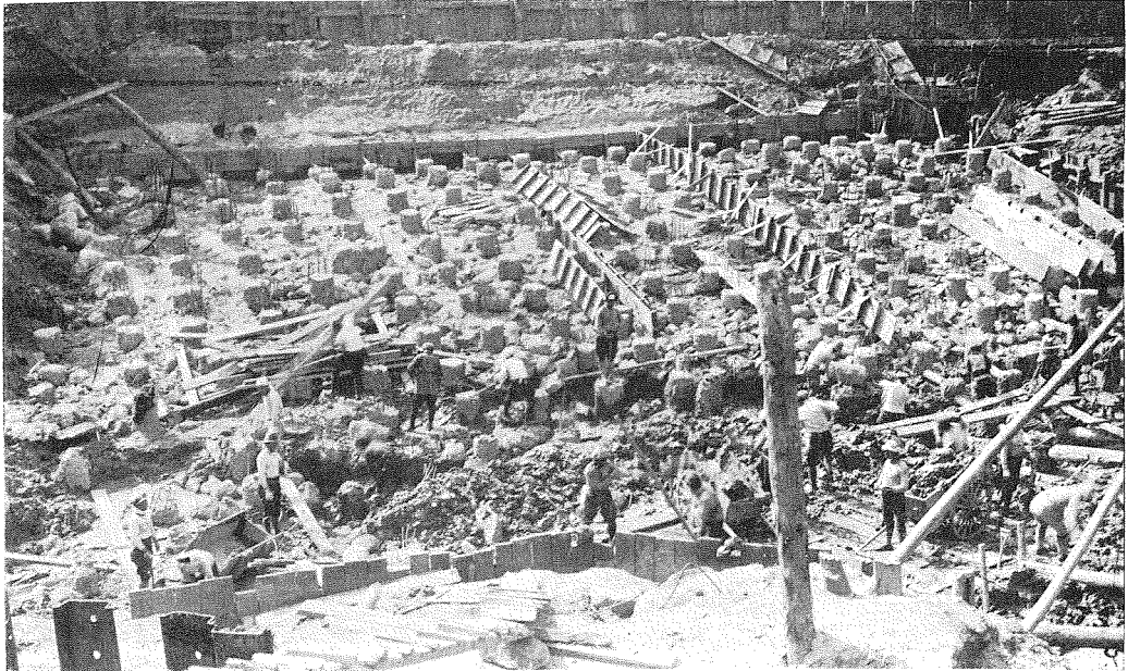
第50圖 淀川新橋基礎工事
