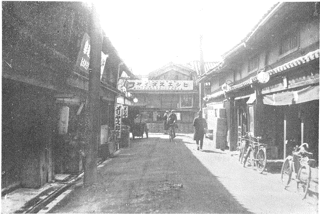
第47圖 同上、施工前の景
