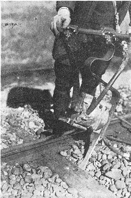
No. 4. 房總線 楡葉工場(楡葉驛の前後)に於て機械を使用する保線作業の一部にして「電気タイタンパー」を使用して道床砂利を搗固めつゝある狀況、寫眞中右方に据付けられてゐるのは米國 Jackson 會社製「ガソリン」使用の發電機である。
