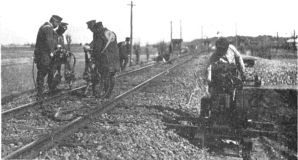
No. 4. 房總線 楡葉工場(楡葉驛の前後)に於て機械を使用する保線作業の一部にして「電気タイタンパー」を使用して道床砂利を搗固めつゝある狀況、寫眞中右方に据付けられてゐるのは米國 Jackson 會社製「ガソリン」使用の發電機である。
