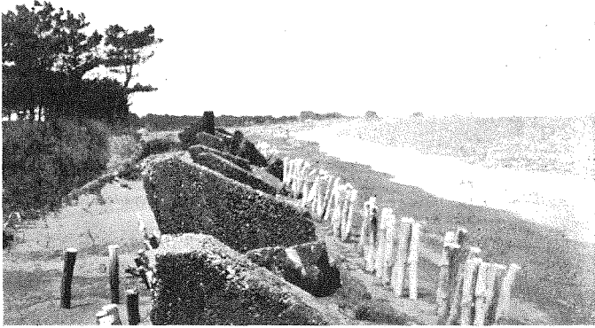
(3) トクシマ縣 ホウザキノ海岸 ニツクラレタ、 アスファルト被 装ノ蛇籠防砂 堤。
