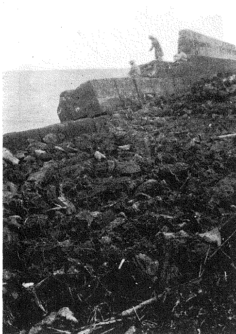
(4) ヨコハマ市シンヤマシタ町海岸コンクリ ート海壁ノコワレマヲ蛇籠デ、ツクラウ。—5年 ヲ經テヨクモテリ。
