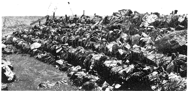
(4) ヨコハマ市シンヤマシタ町海岸コンクリ ート海壁ノコワレマヲ蛇籠デ、ツクラウ。—5年 ヲ經テヨクモテリ。
