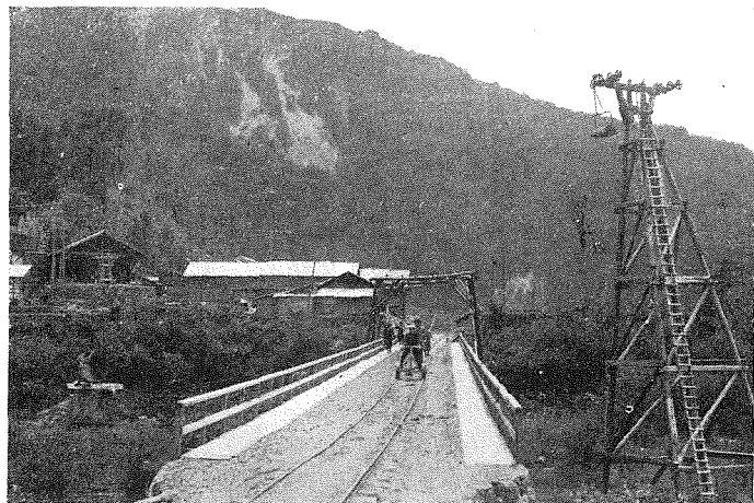
(第6圖) 中州索道停車場及早川入り軌道の景、軌道延長13.5哩、ゲージ2'-6"
