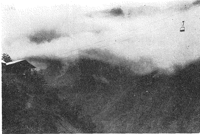
(第7圖) 廣河原索道停車場の景、索道は玉村式にして10.5哩、運搬能力1晝夜最大記録250噸、搬器 \frac{1}{6} 噸。
