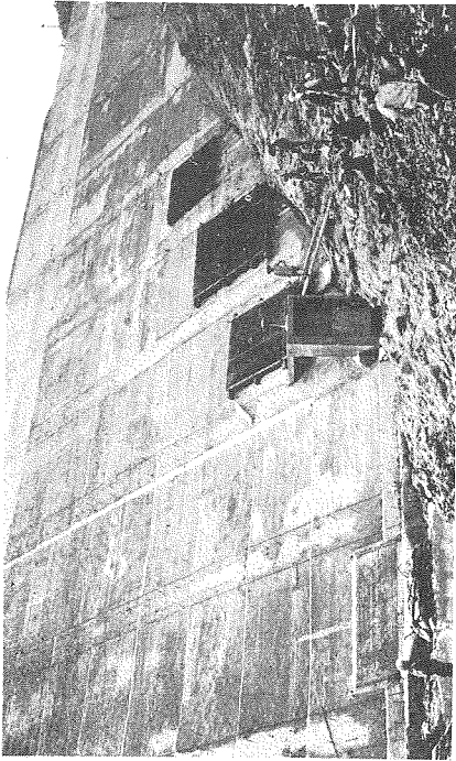
(4) ダム前面カーテン及び取水口配置の状況 (3段になつてゐる角が取水口。スクリーン下が最満水時の 取入口、ゲート左が排砂口、土俵にて閉つ)
