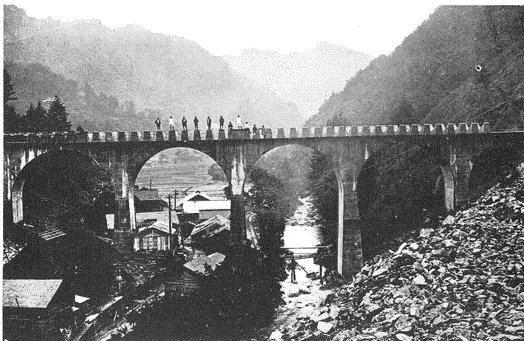
(8) 太田川發電所水路橋。徑間40尺6連、混凝土拱橋
