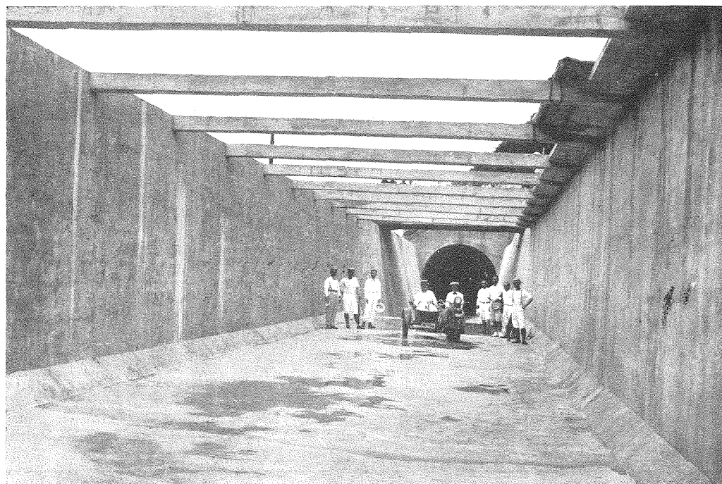
(4) 江ノ川水路鐵筋混凝土水路橋内部を示す。幅20尺高12.5尺水深10.5尺、側壁床版共厚15吋
