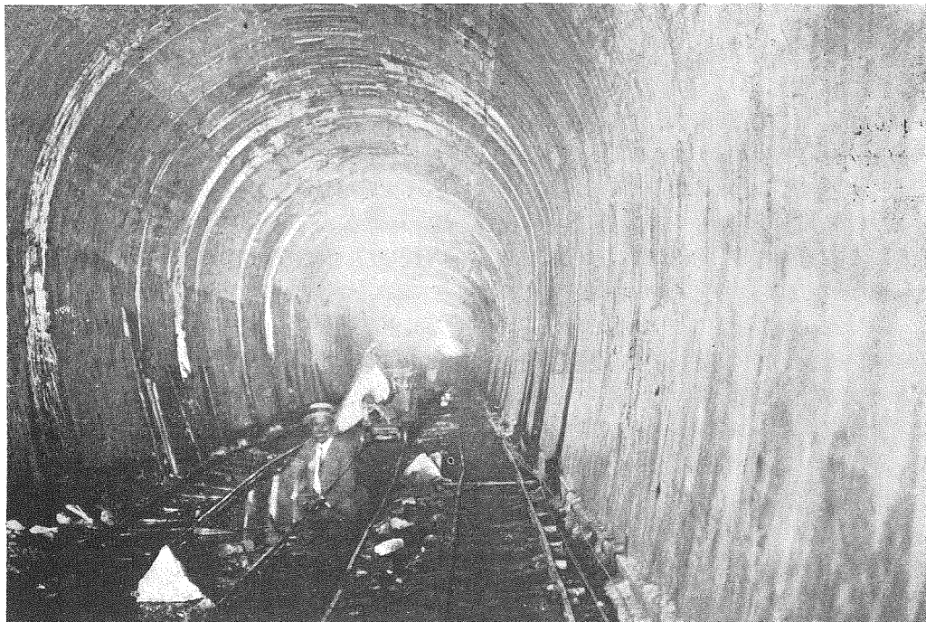
(3) 江ノ川發電所水路隧道(内徑16呎馬蹄形にして水深14尺)
