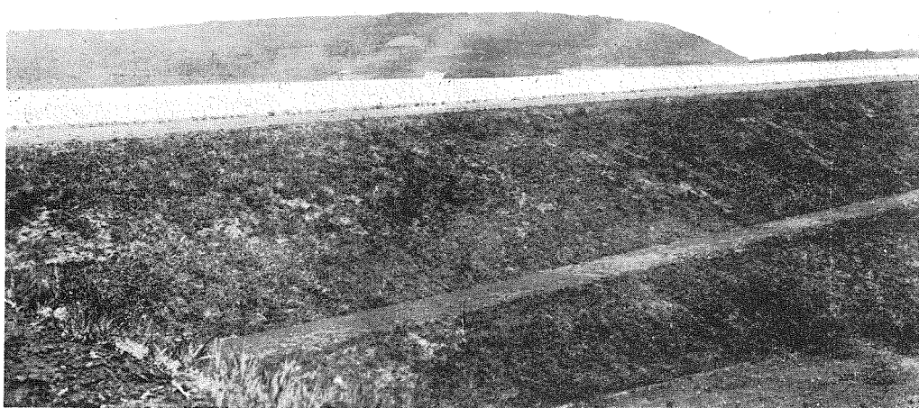
(3) 完成満水せる貯水池と土堰堤の一部
