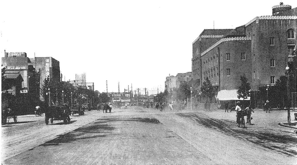
(5) 電柱のない街路。所謂濱町線で電線等の架空線は全部地下共同溝内に收められ、郊囲になる一本の電柱もない。樞要なる街路は漸次斯くの如く面目を一新してくる。
