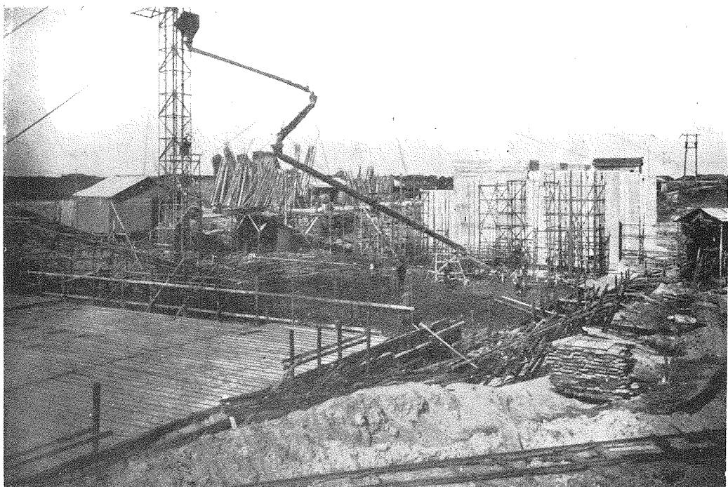
(2) 防潮閘門工事の基礎鉄筋組立並に混凝土施工中の景
