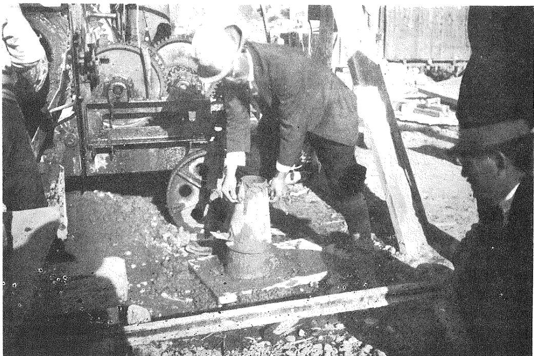
(3) 同、混凝土工事のスランプテスト
