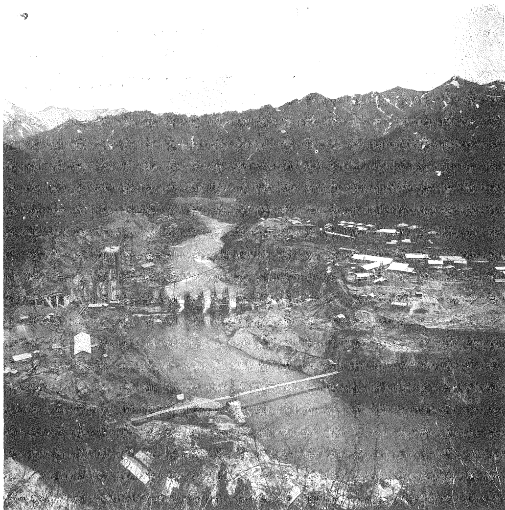
堰堤コンクリート工事中（4月25日撮影）
