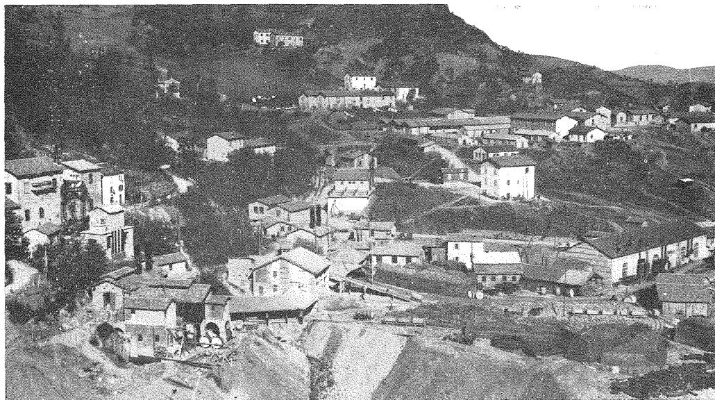
(1) アペニン山隧道のシャフト坑外の景である、寫眞の左下方がシャフトの上屋で其所にエレベーター其他の設備があり、欄捨の谷に臨んでゐる。
