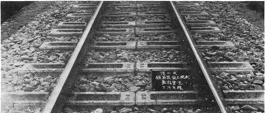
(3) 深川式鐵筋混凝土枕木鐵道省下河原敷設の景
