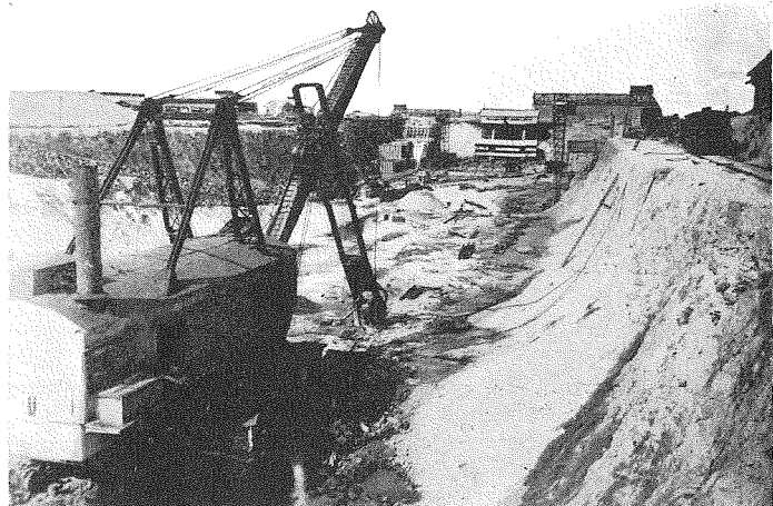
(8) 船渠築工事に於ける掘鑿 竝混凝土施行の遠景
