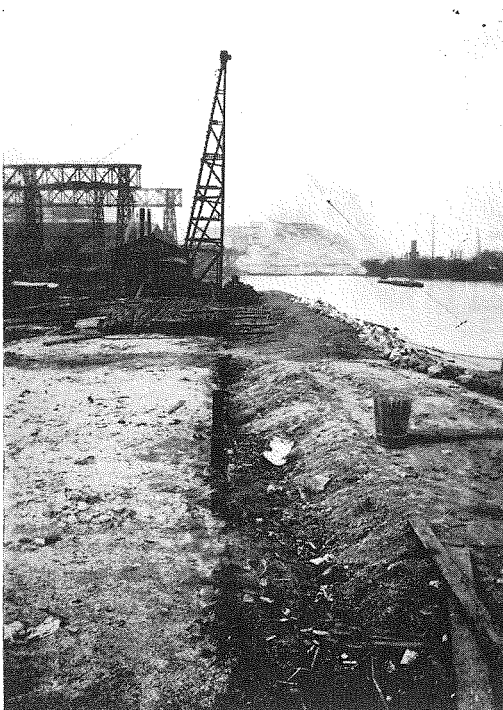
(5) 締切堰堤中心にシート・パイル打込み作業(其一) タワーの高さ60呎 スチームハンマー・マツキーナン・テラー型 No. 7 (5,000#) シートパイルの長さ最長52呎
