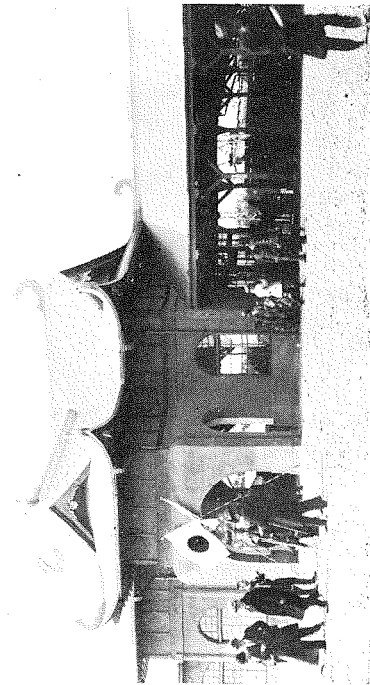
(2) 小田原急行鐵道、片瀬江ノ島停車場 本屋 48、6坪 鐵筋混凝土建 上屋 104坪 待合室 6坪
