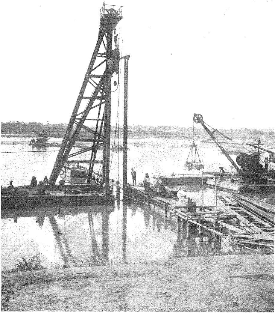
(3) 可動堰鋼矢板打込作業と床堀作業
