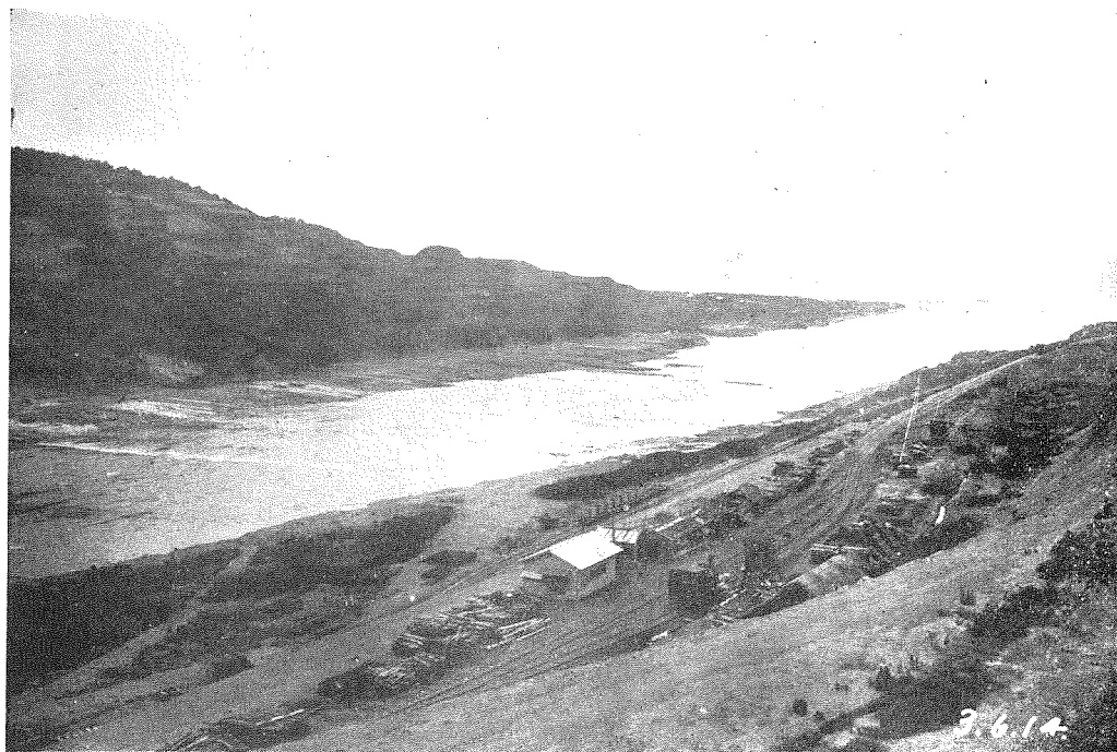
(5) 分水路終端と第二床固堰堤箇所 (3年6月14日)
