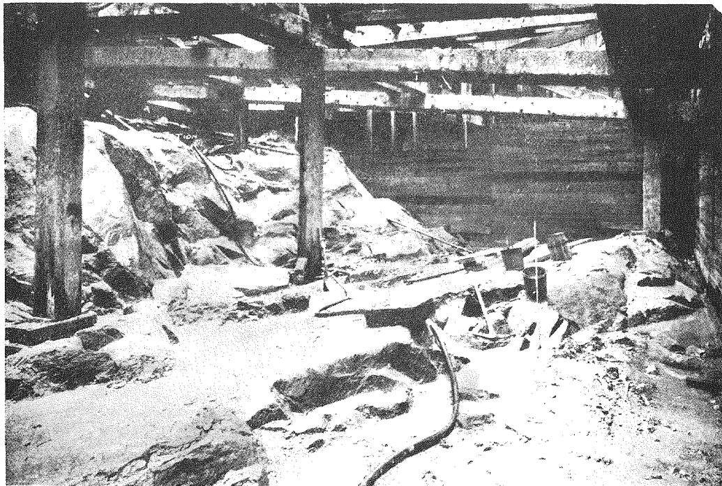
(15) ハドソン橋鐵塔基礎工事、締切内にて水面下50呎迄掘鑿したる海岸寄りの岩盤面の景
