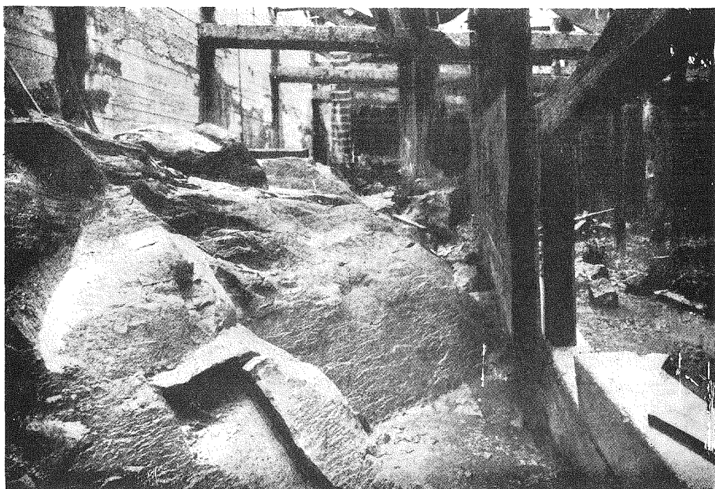
(16) 同締切内にて水面下65呎迄掘鑿したる川岸寄りの岩盤面の景
