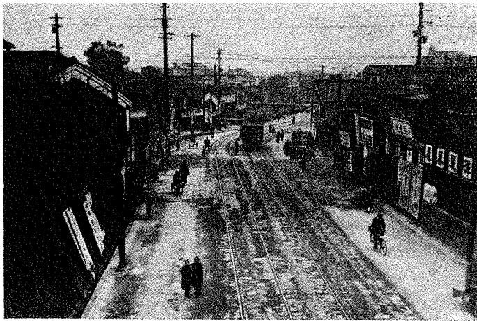
(9) 同 上——工事前の舊景
