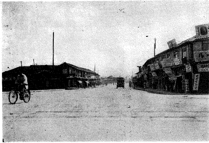
(16) 大阪奈良線——竣工後の景
