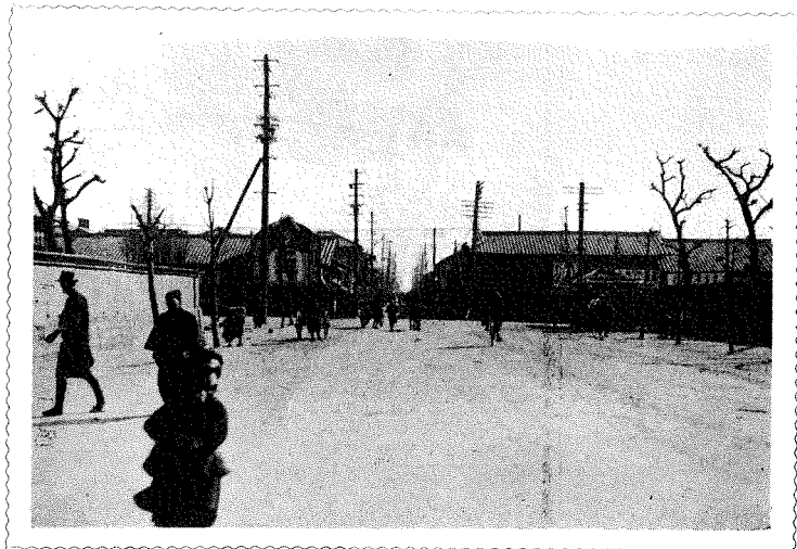
(11) 同上——工事前の景
