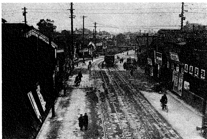
(9) 同 上——工事前の舊景
