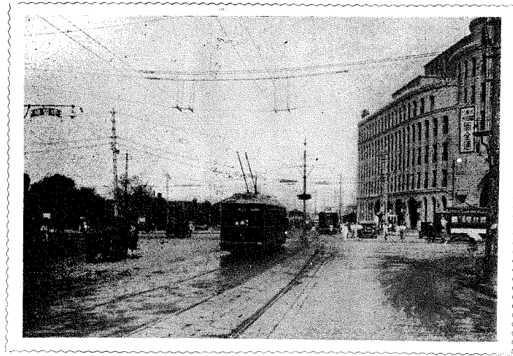
(14) 鶴橋線——竣工後の景
